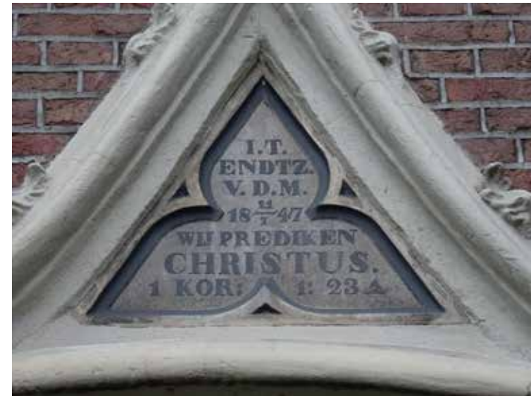
Afb. 4 Opschrift in de driepas boven de hoofdingang aan de straatzijde. De datum verwijst naar de eerste steenlegging van de kerk. (Collectie RHCE)
